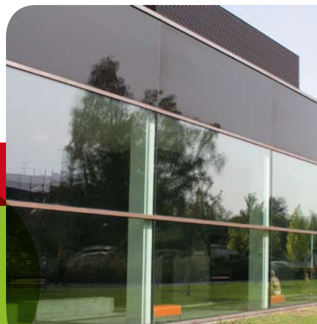
Voyage d'études en Autriche sur le thème de la performance énergétique (bâtiment d'habitation et piscine)
