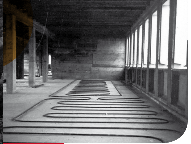
Bâtiment administratif du Costic (dalle pleine) construit en 1960
