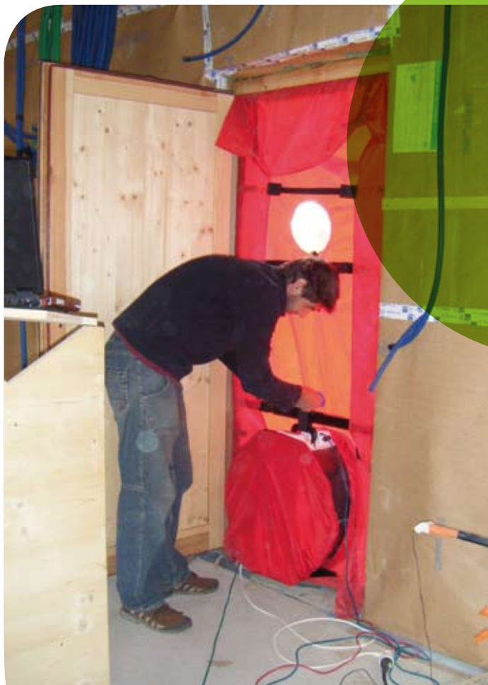
Tests de perméabilité à l'air du bâtiment
