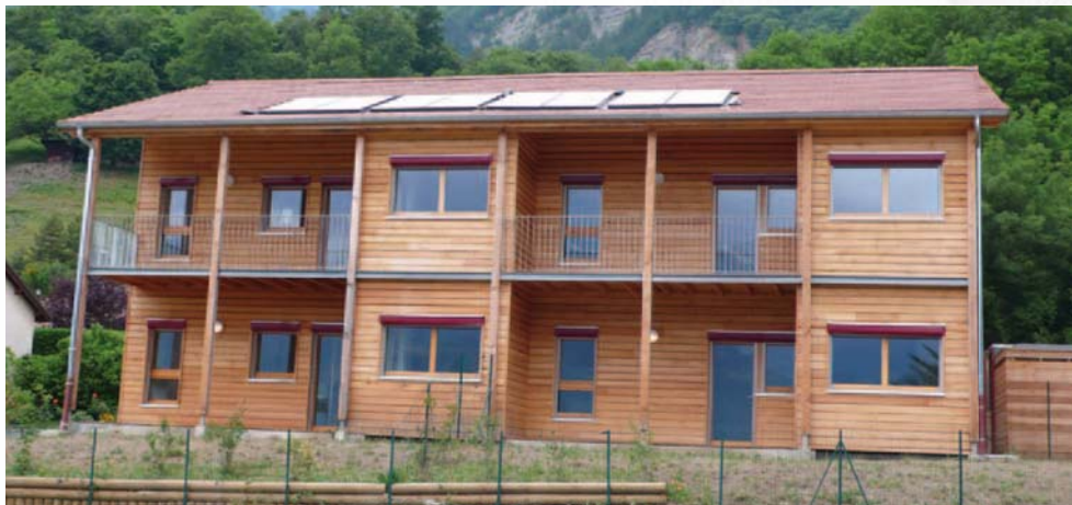
Le COSTIC suit, enregistre et analyse les consommations réelles et les paramètres du confort dans 6 logements à basse consommation en Rhône-Alpes.
